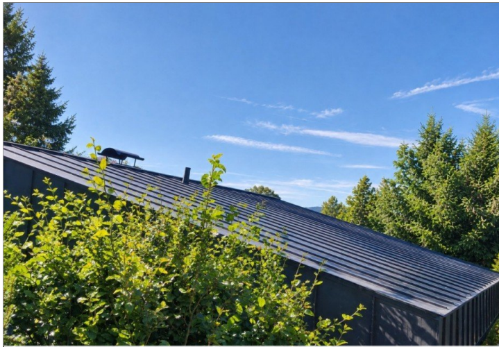
das hochwertige Kupferdach
